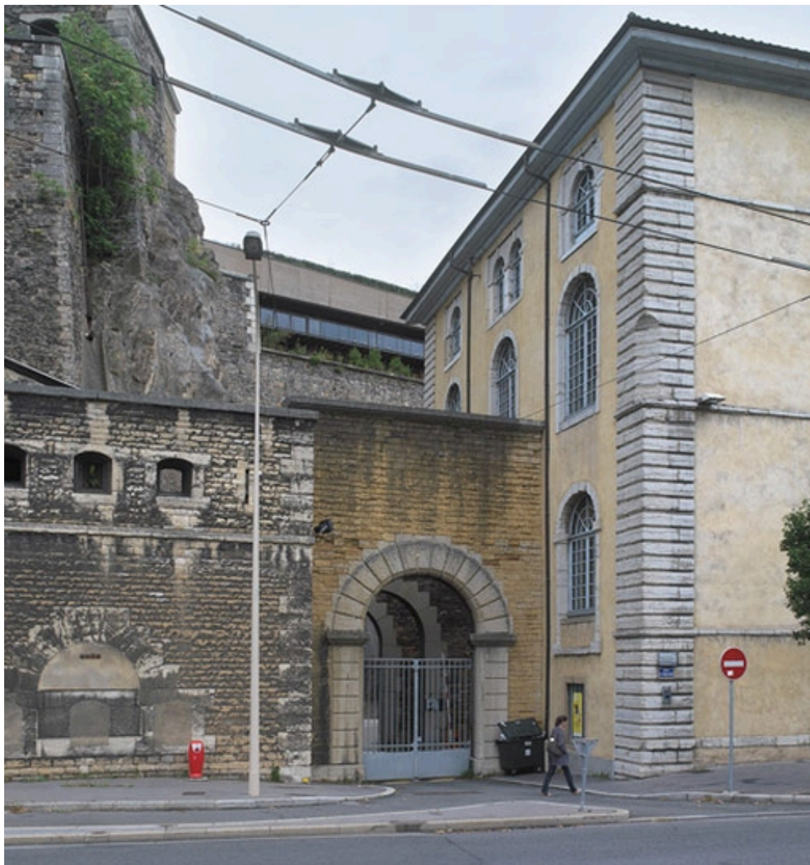
Entrée nord, pignon nord.
