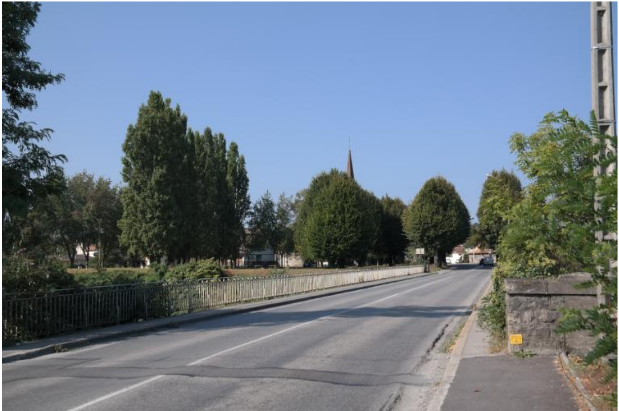
Pont de Dranse, vue de la chaussée
