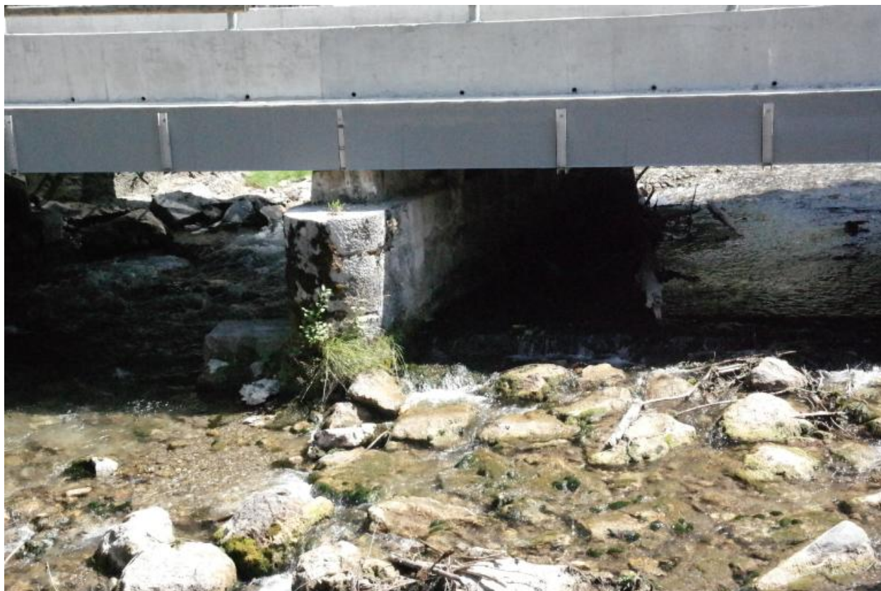
Ancient pont couvert d'Abondance, vue de la pile centrale
