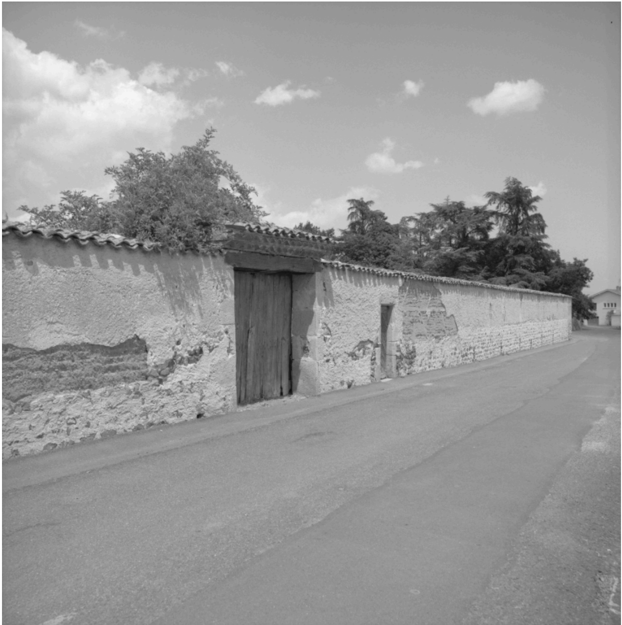
Détail du mur de clôture du parc, en pisé.
