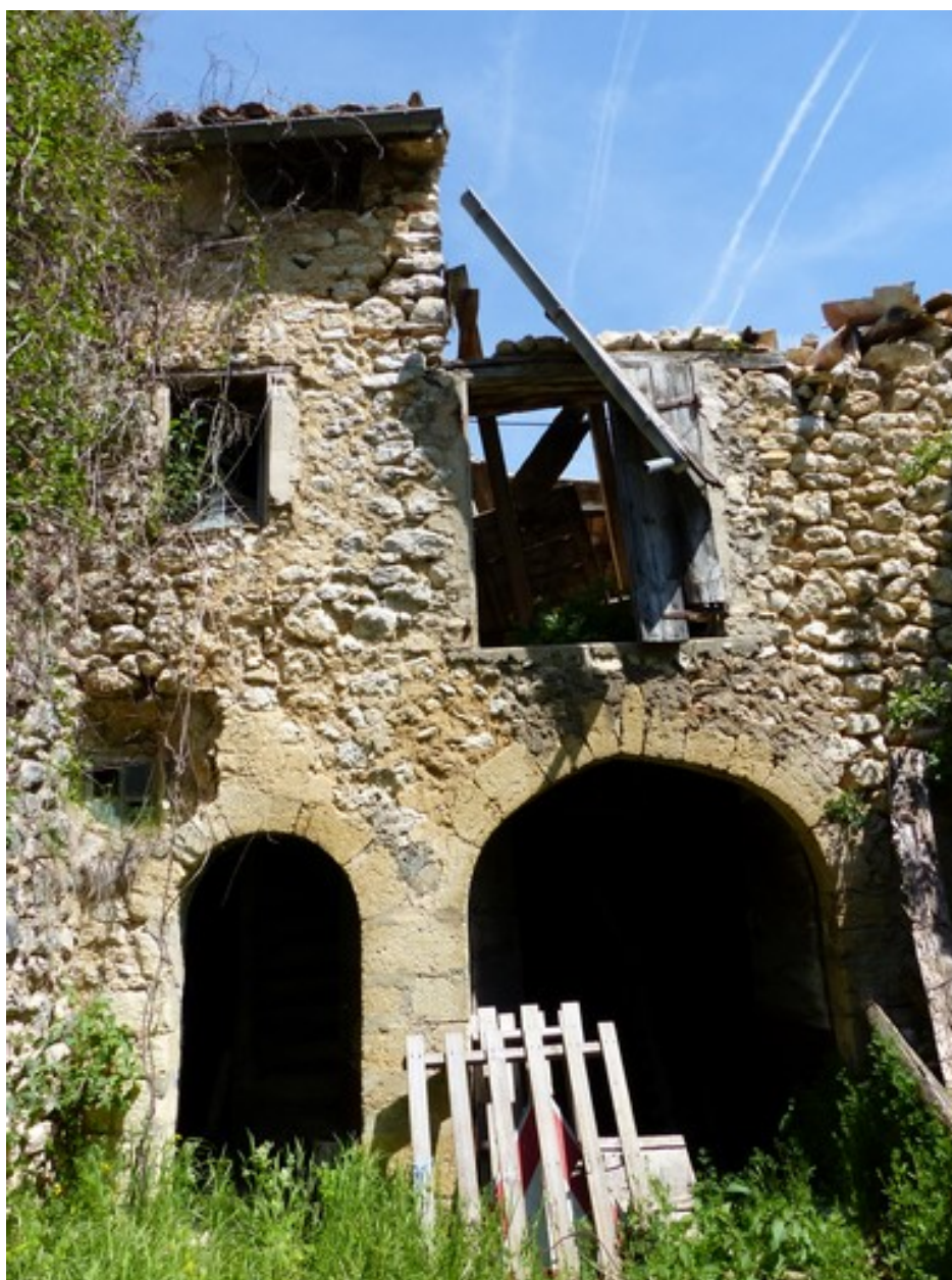
Ensemble oriental. Partie centrale. Elévation ouest.
