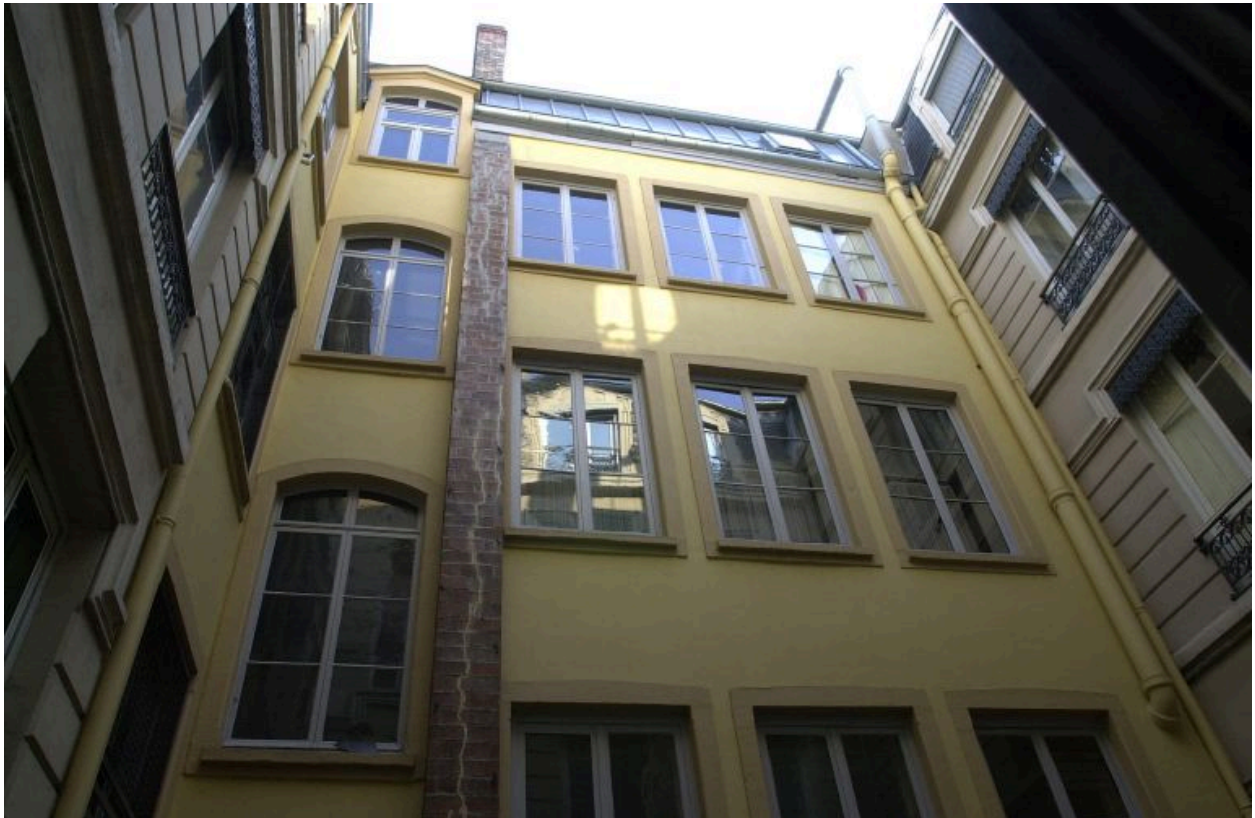
Façade sur la cour commune, partie supérieure
