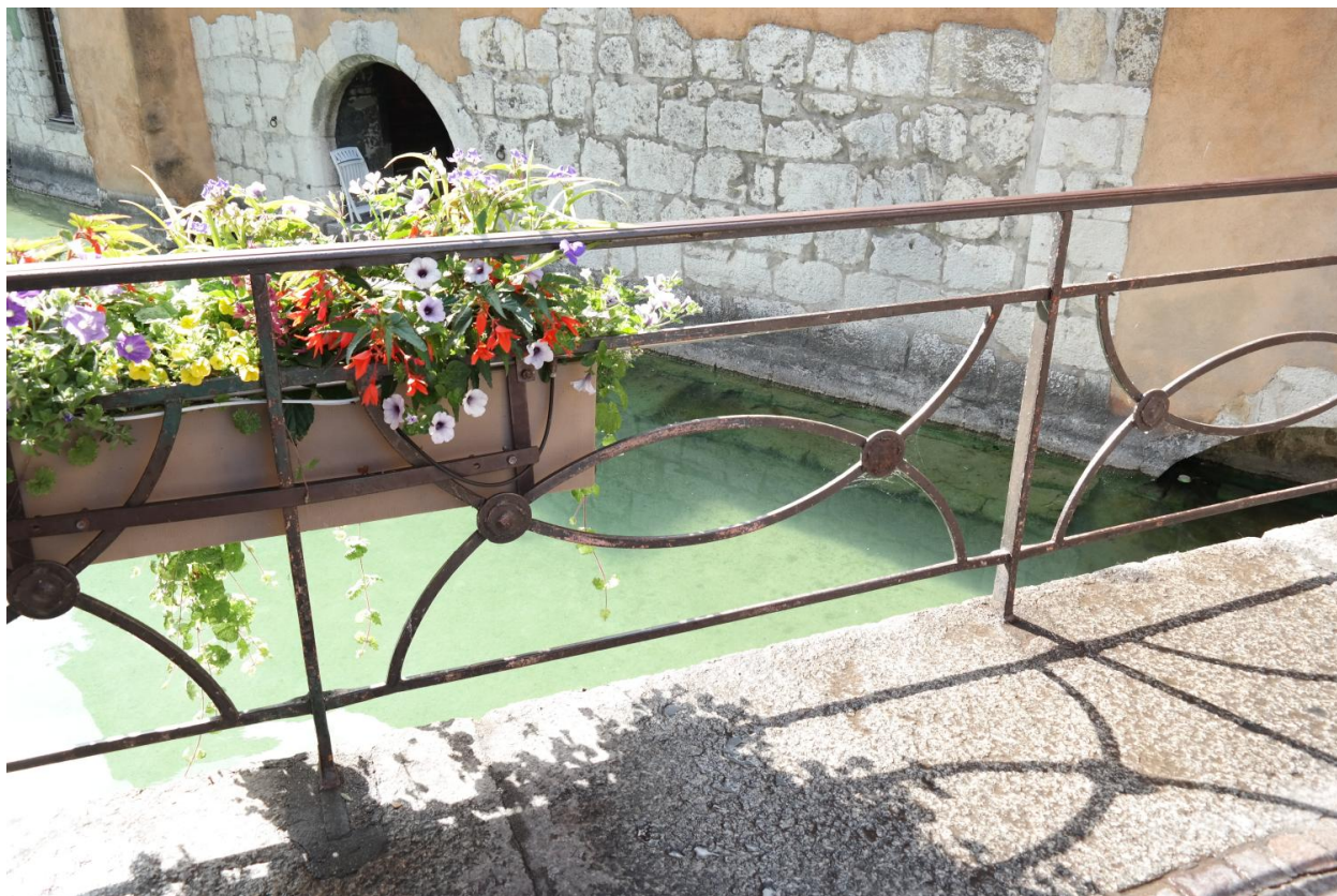
Pont Morens, détail des garde-corps
