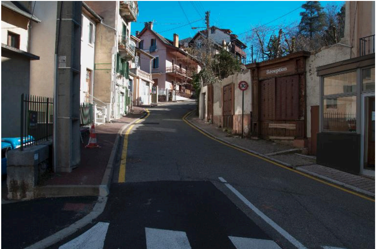
Partie basse de la rue, démolition d'une annexe de l'hôtel de la Grotte, août 2015
