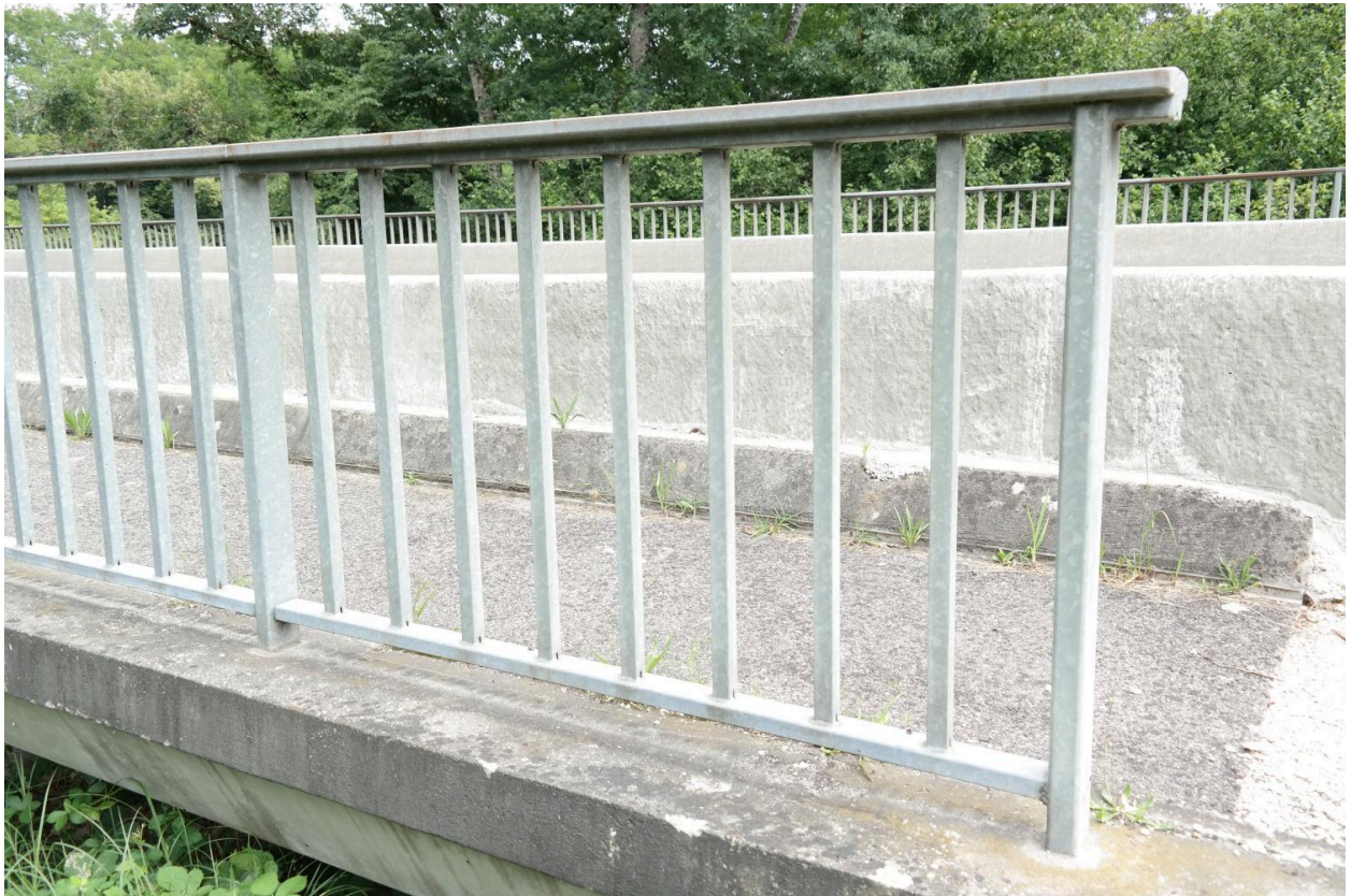
Pont Mottet, détail des garde-corps métalliques
