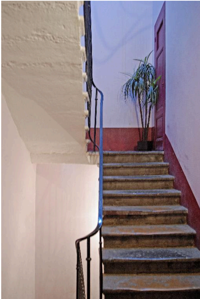
34 rue Montesquieu, escalier dans-oeuvre
