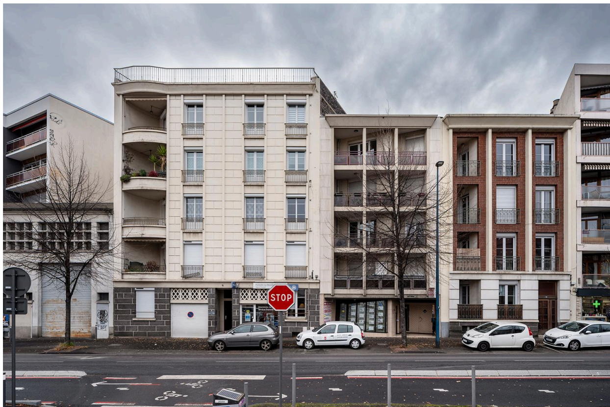
Façades sur le boulevard Aristide-Briand
