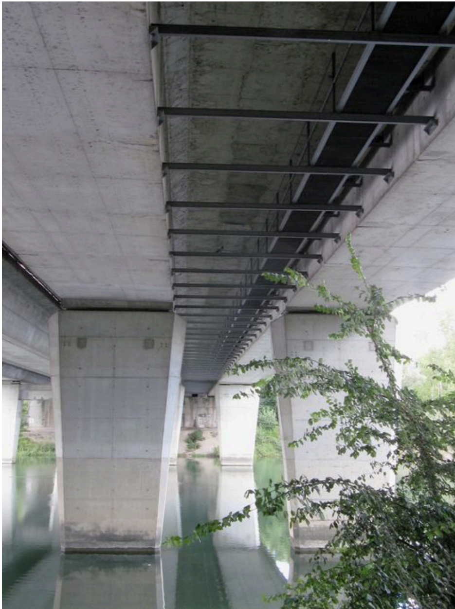
Tablier amont vu de dessous (depuis la rive gauche)
