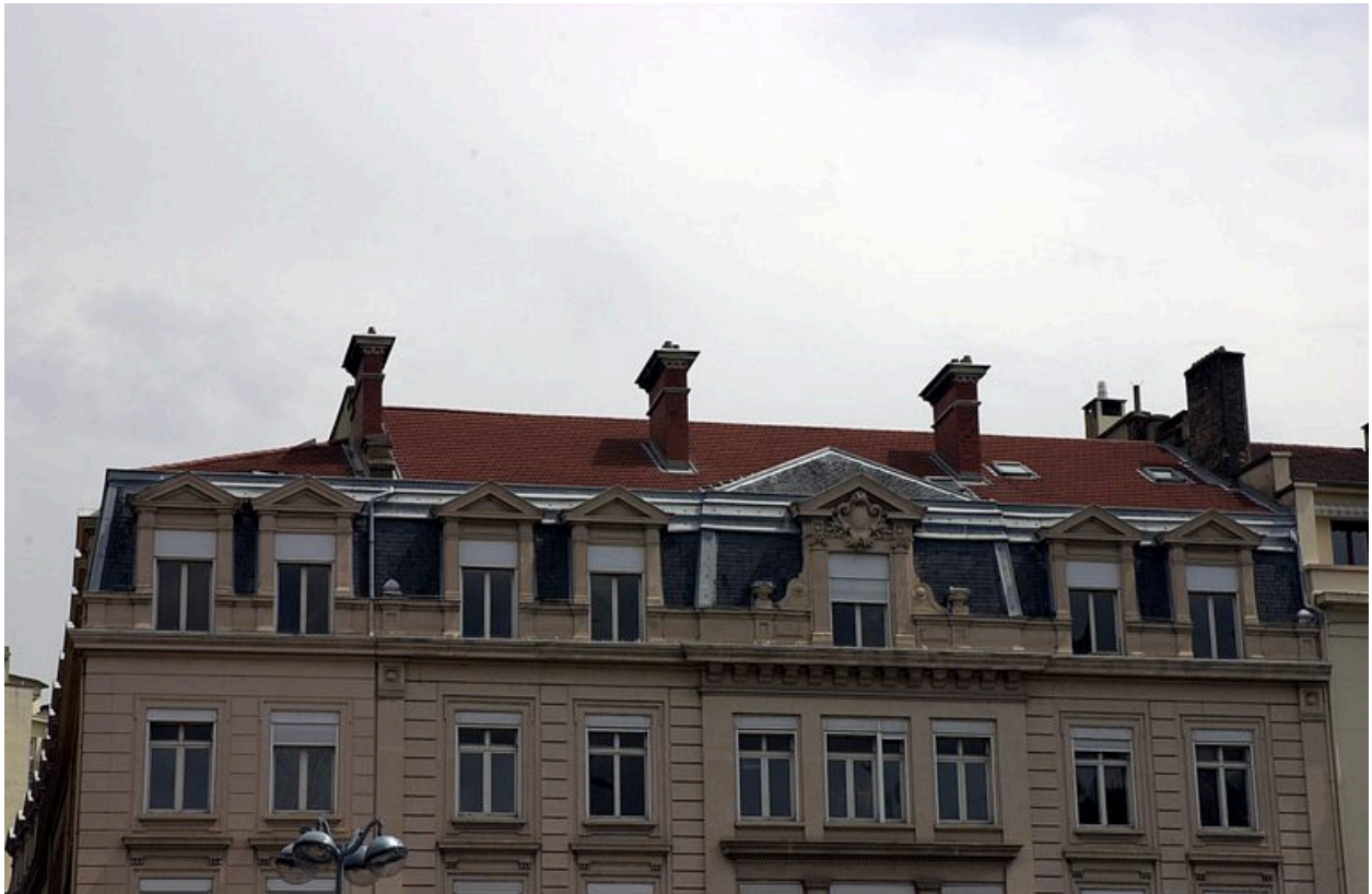
Toit du 3 quai des Célestins
