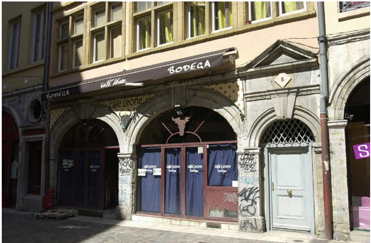
Elévation rue de la Monnaie : le rez-de-chaussée
