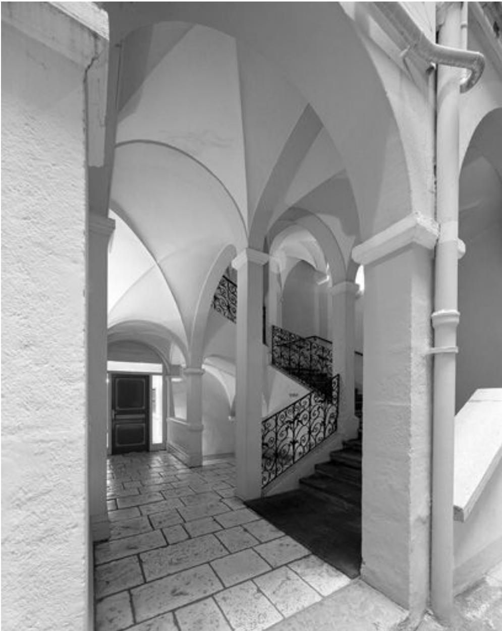
1er bâtiment, rez-de-chaussée de l'escalier
