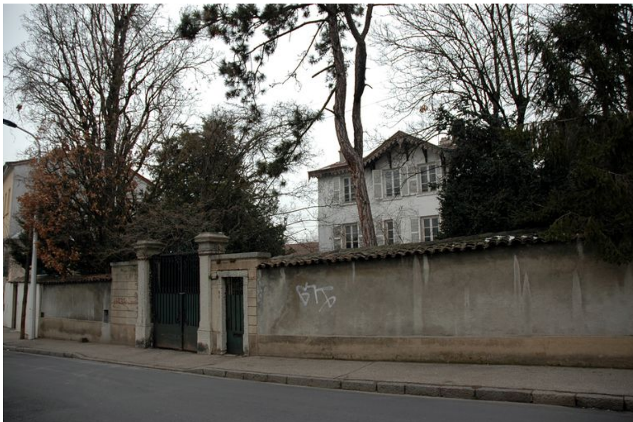
Vue d'ensemble depuis l'avenue
