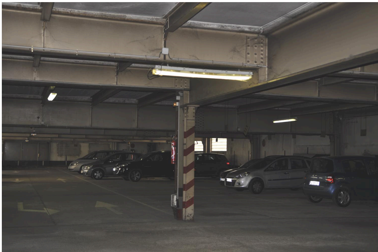
Vue intérieure du parking souterrain
