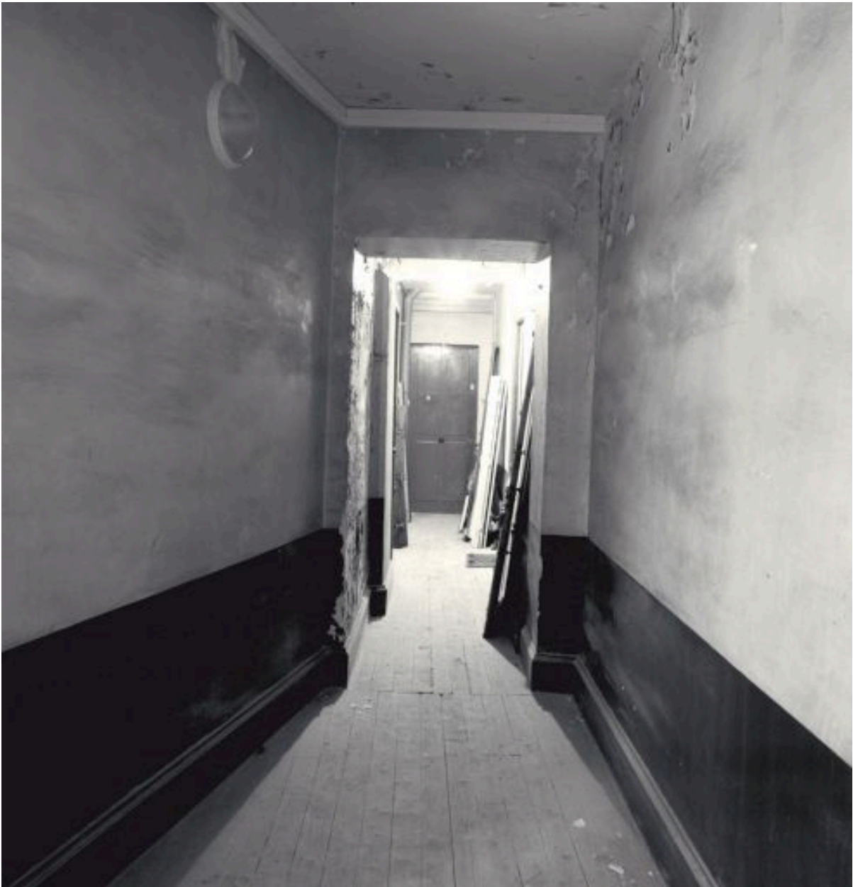
Vue d'un couloir de distribution des logements
