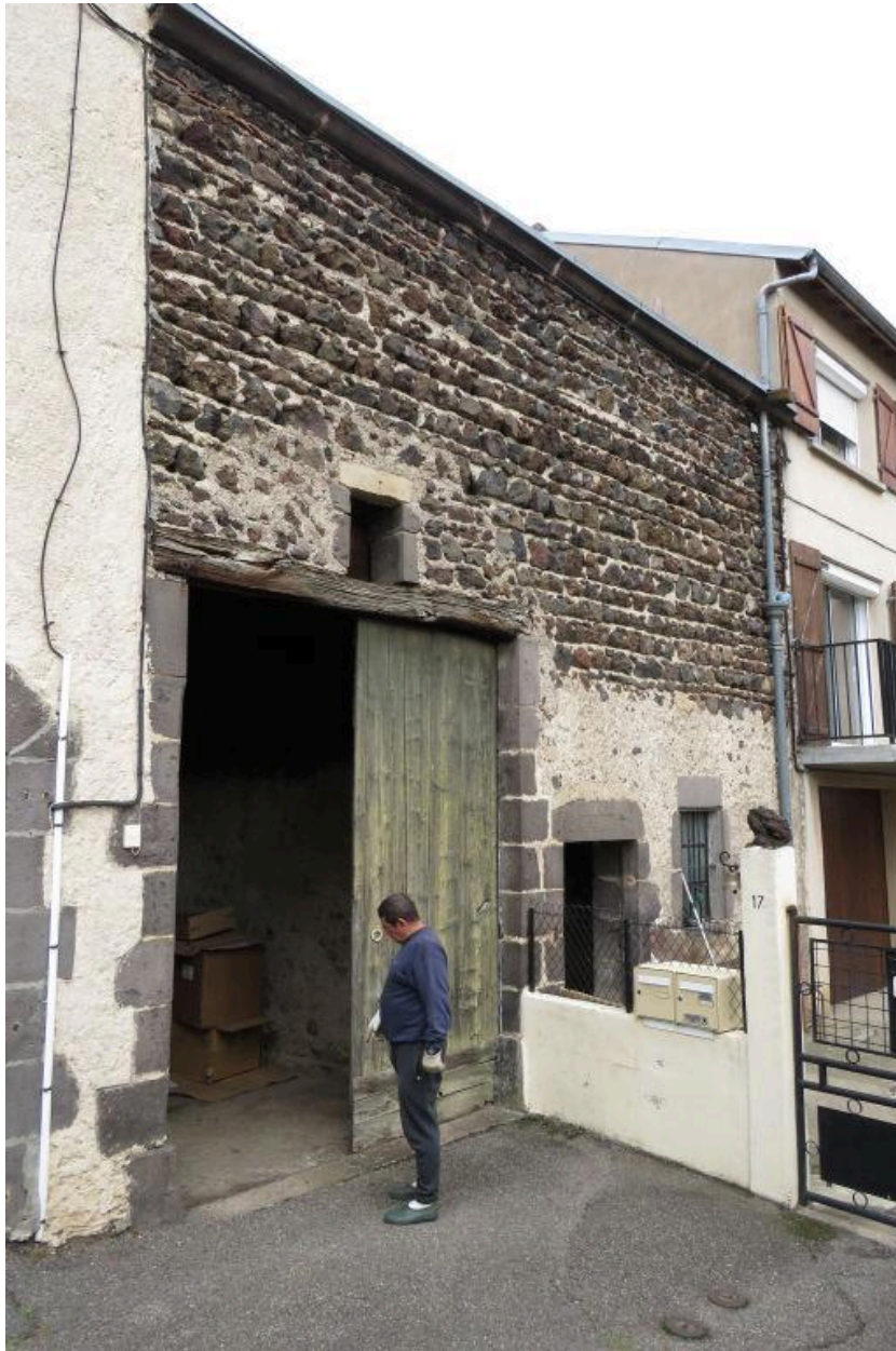
Vue générale : façade (grange, bergerie, toits à cochons ...)
