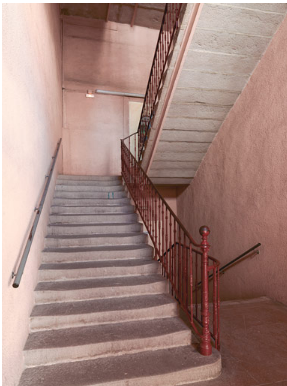
Escalier construit en 1867 pour relier les bâtiments B, C et D.
