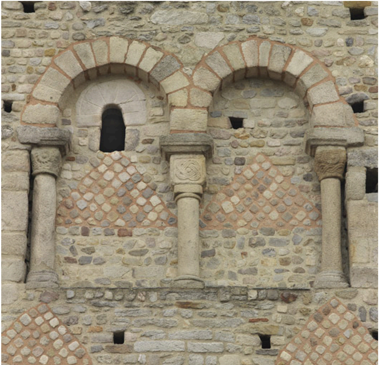
Détail de baies jumelées murées du clocher, face est
