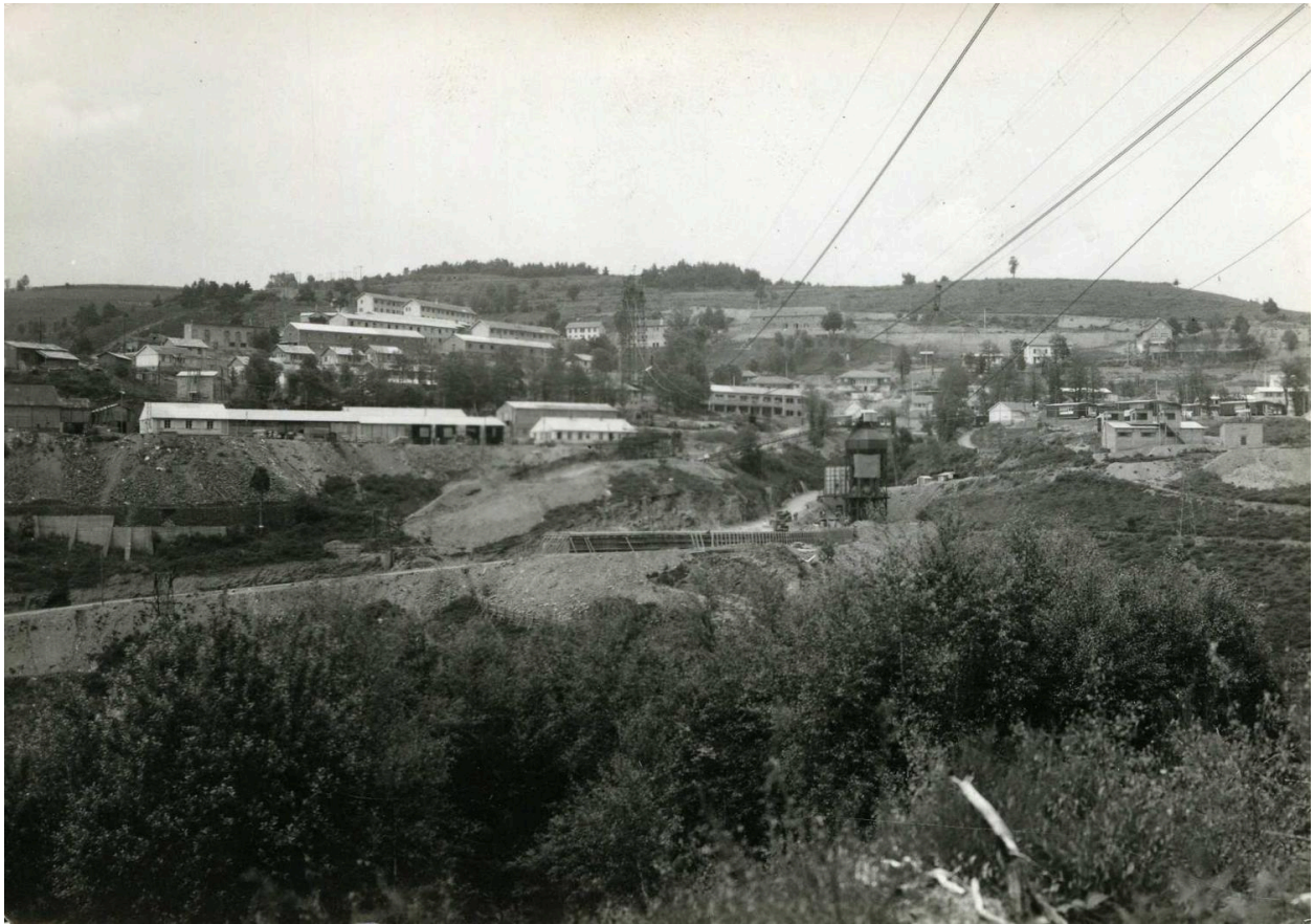
Neuvéglise-sur-Truyère - Fridefont, barrage de Grandval, les installations de chantier et la cité sur le flanc nord de la vallée, n. d, vers 1958 (Archives départementales du Cantal, Murat, photo Jack Andral, 2 Fi 1363).
