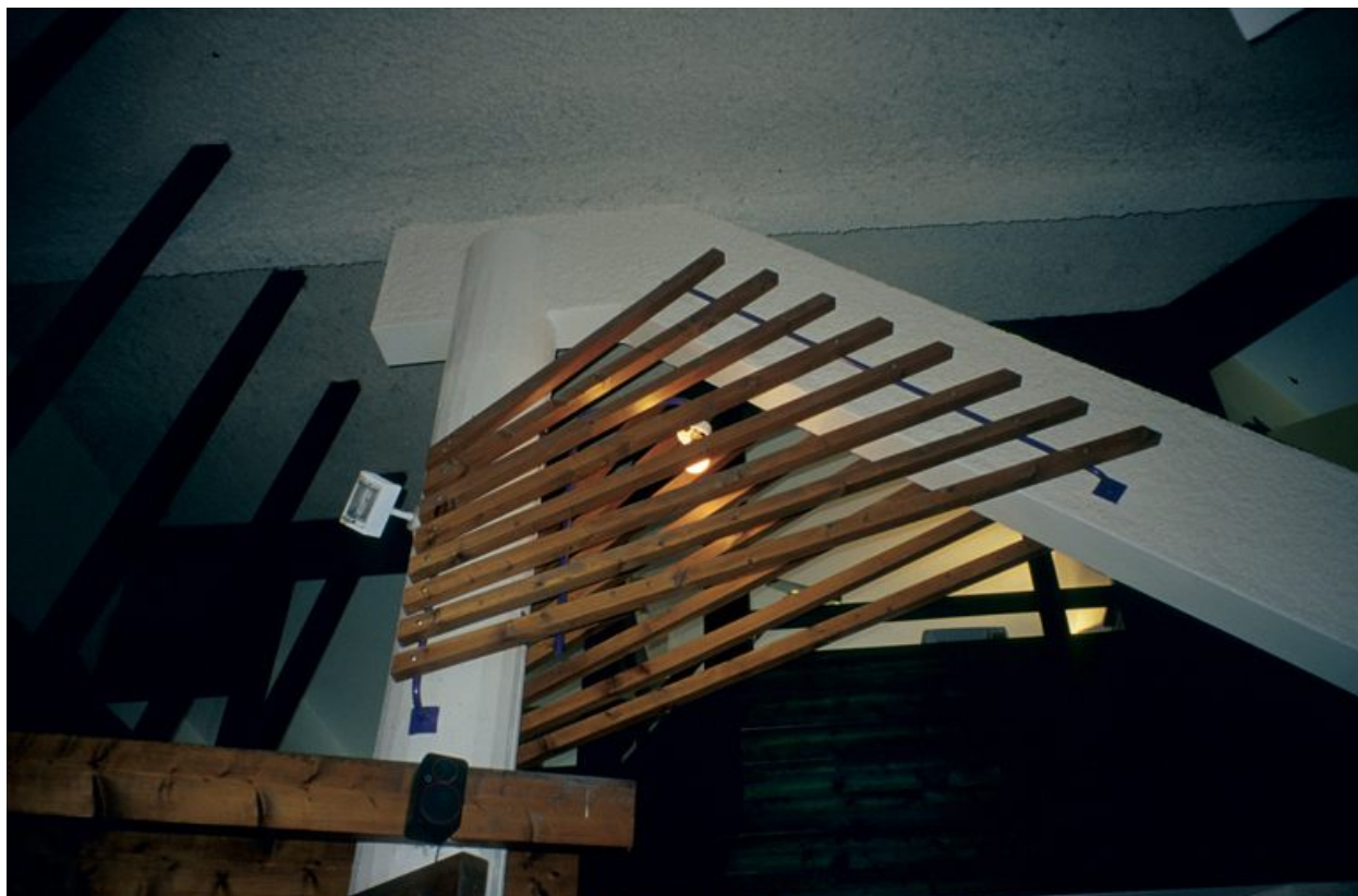
Détail du couvrement à l'étage
