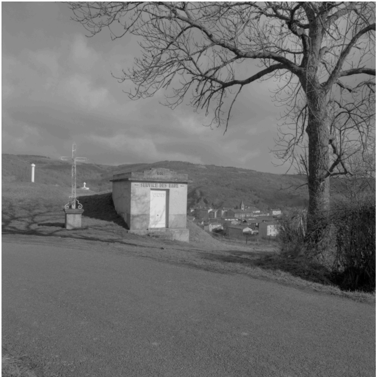
Vue d'ensemble du château d'eau des Plans.
