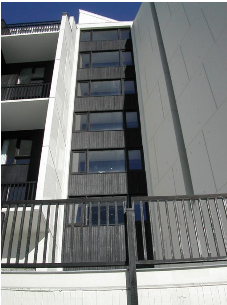
Détail d'une travée d'ouvertures
