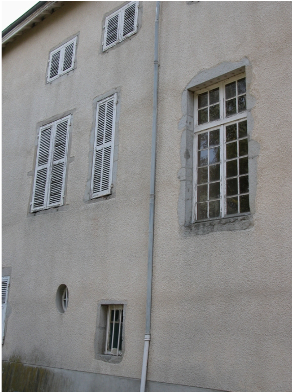
Détail des fenêtres de l'élévation nord de l'aile nord.
