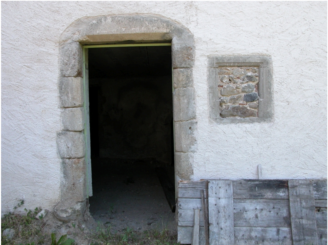
Vue de la porte ouest de l'étage de soubassement.
