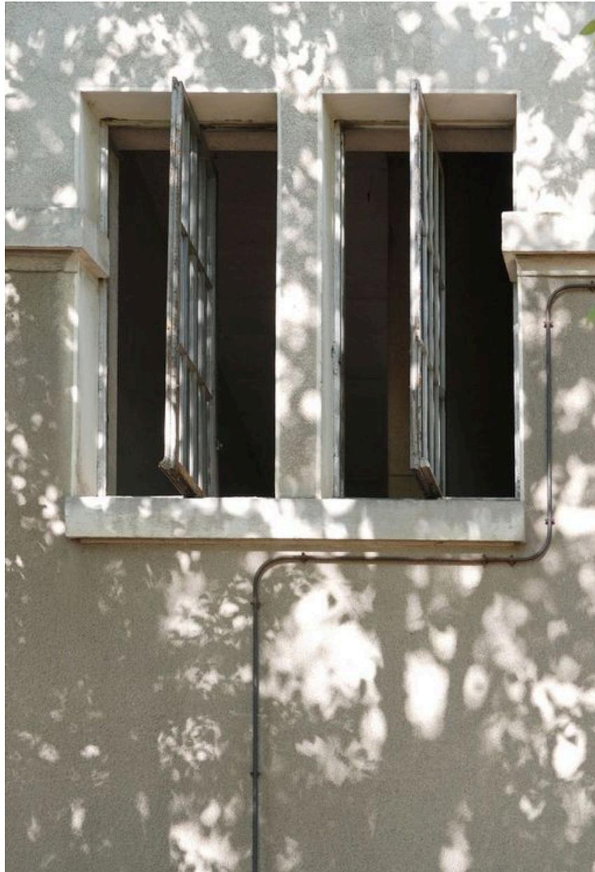
Détail du système d'ouvertures pivotant, façade est
