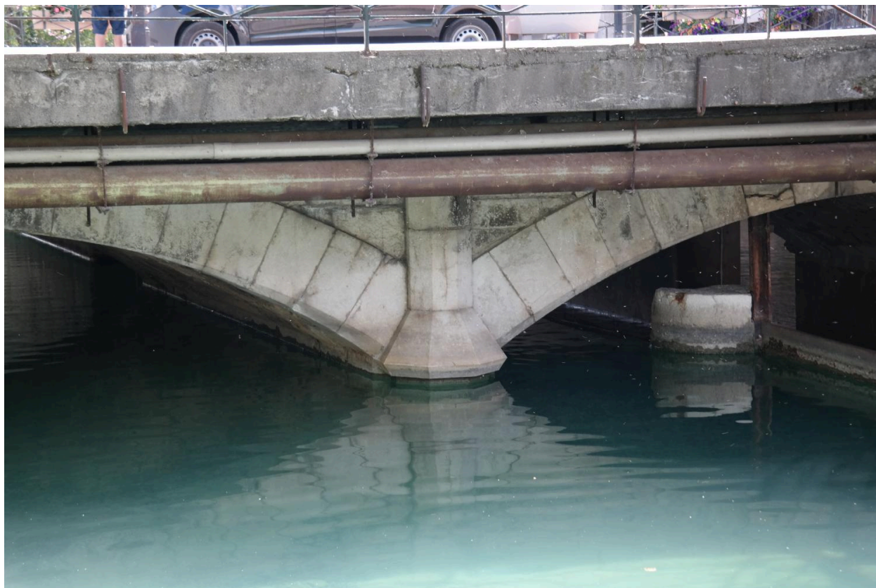
Pont rue de la gare, détail des voûtes en face aval
