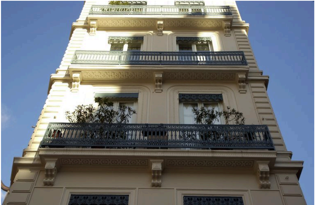
Baies et balcons de l'élévation sud
