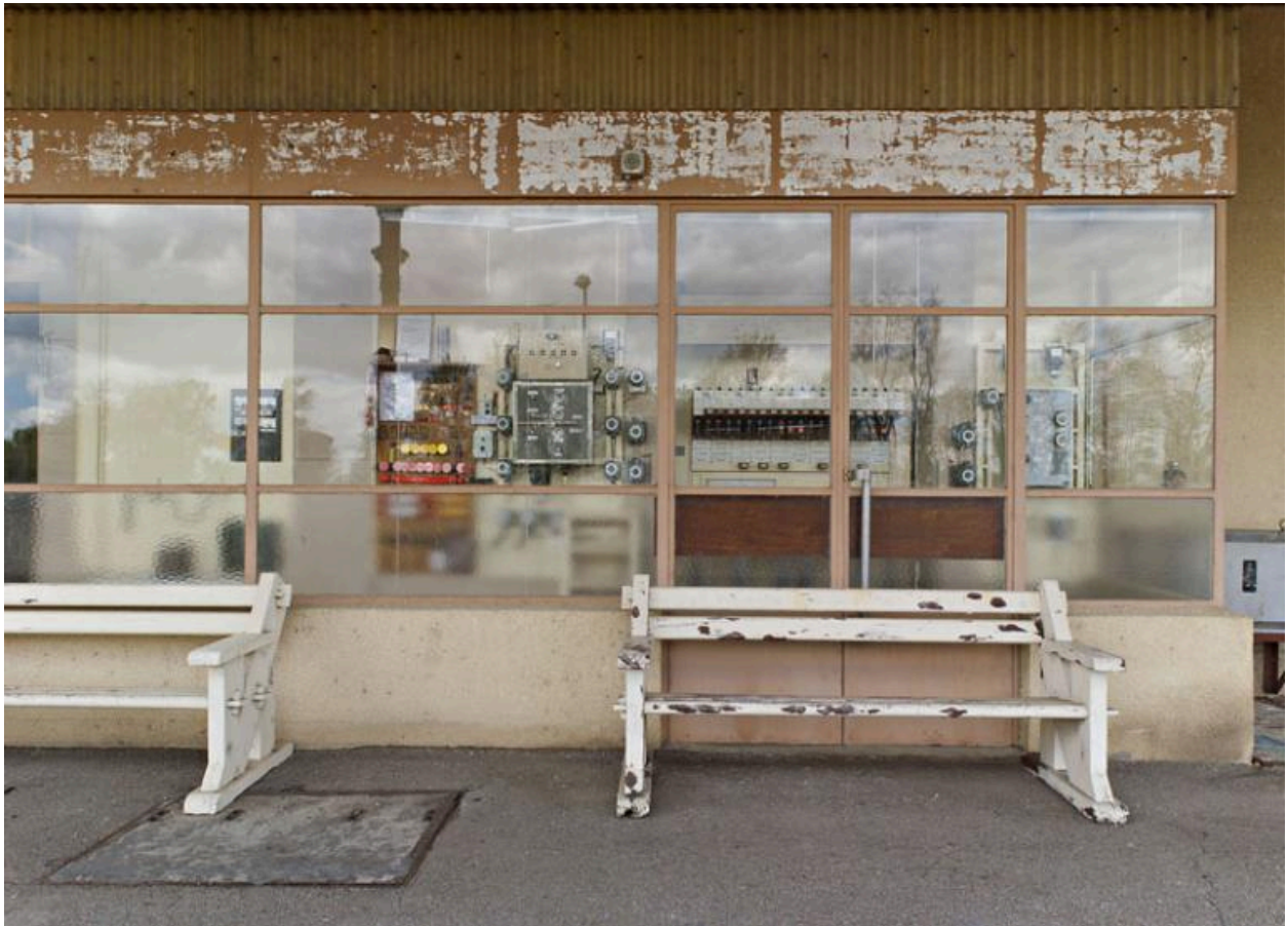
Détail de la salle des commandes de la gare de Lapeyrouse, vue depuis le quai des voyageurs.
