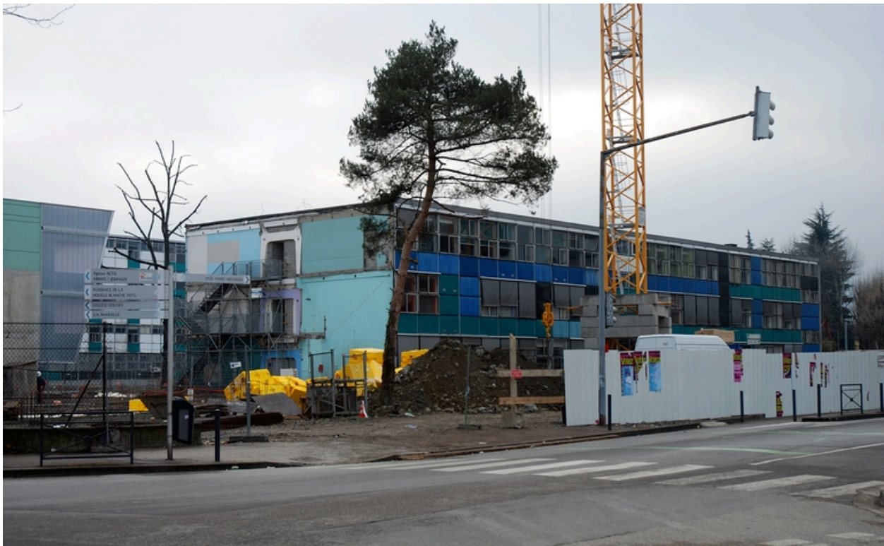
Le bâtiment de la restauration, en 2009
