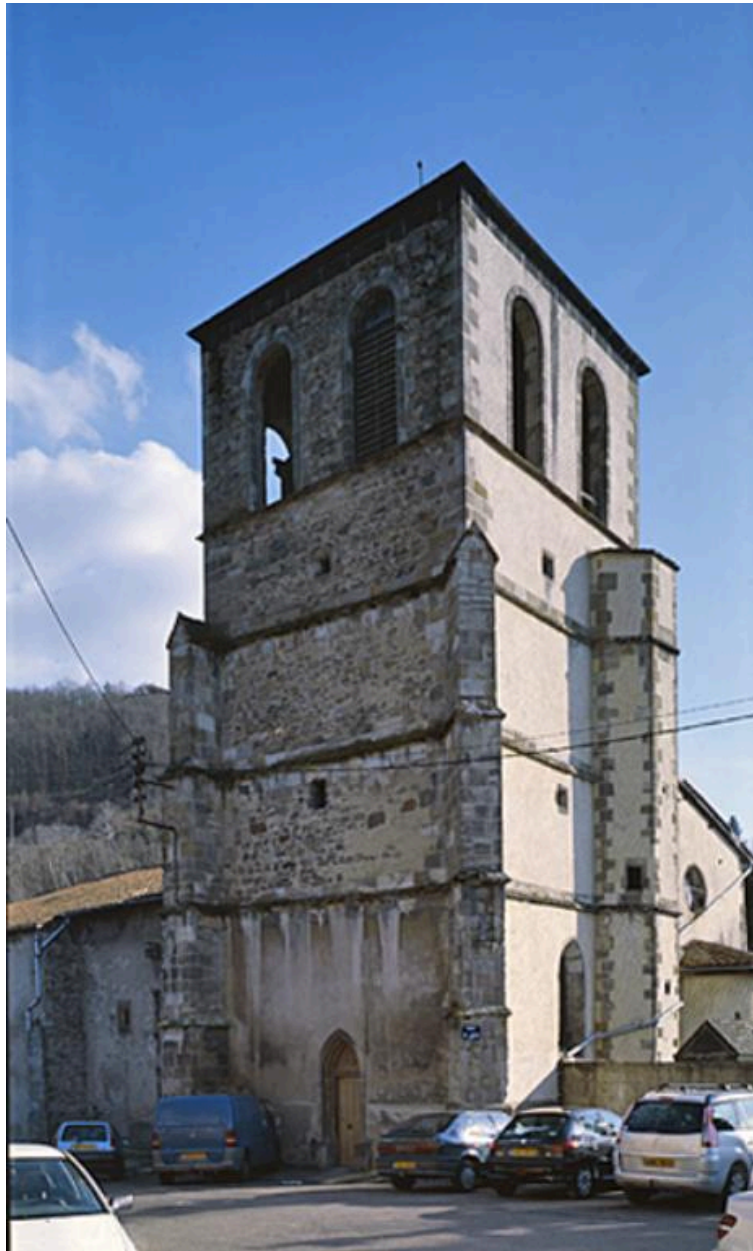
Le clocher de l'église et sa tourelle d'escalier, depuis le nord-ouest.
