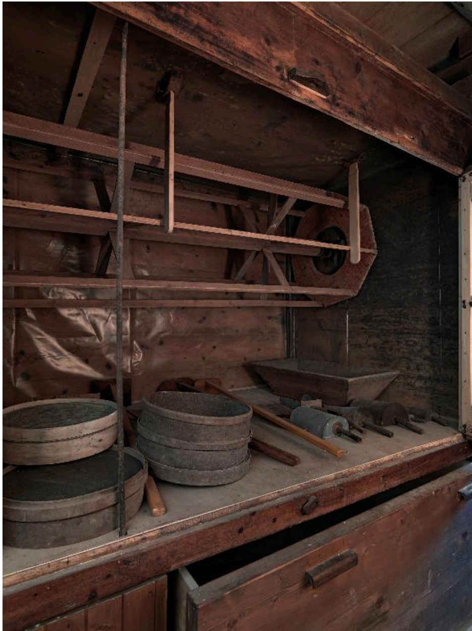
Etage de soubassement : blutoir (vue de l'intérieur).
