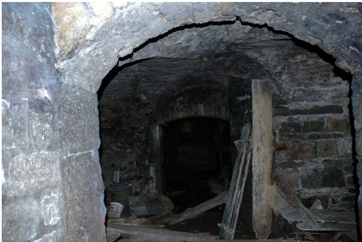
Couvent : 3 rue des Templiers, caves : arc de passage et voûte d'arêtes
