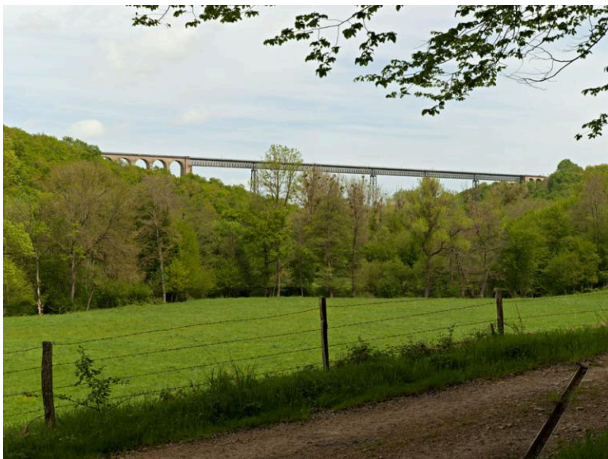
Vue d'ensemble du viaduc de la Bouble depuis le sud.
