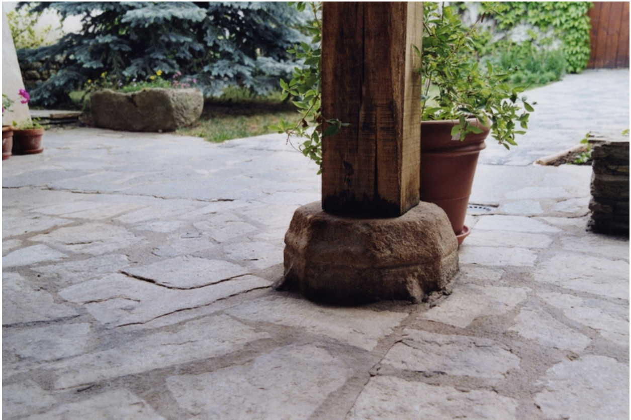
Détail d'un dé de pierre à la base d'un pilier en bois.
