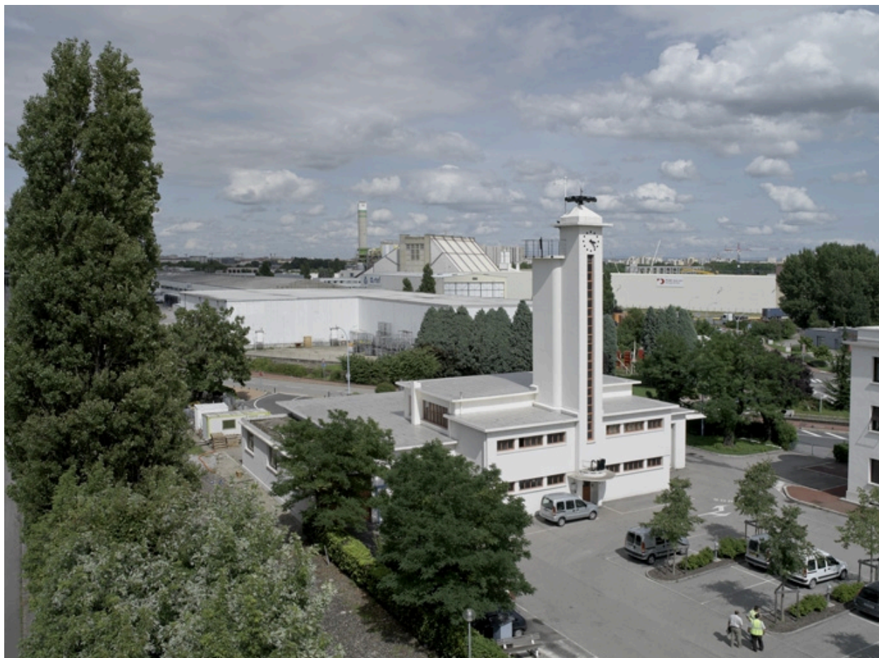
Bâtiment technique avec mirador
