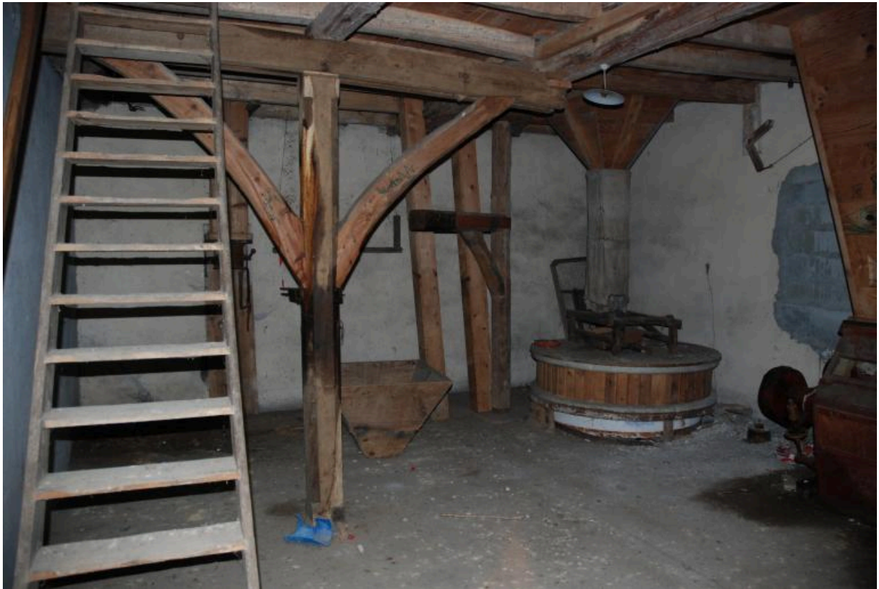
Vue intérieure du rez-de-chaussée, partie nord : meule dans l'angle nord-est, potence, trémie d'ensachage.
