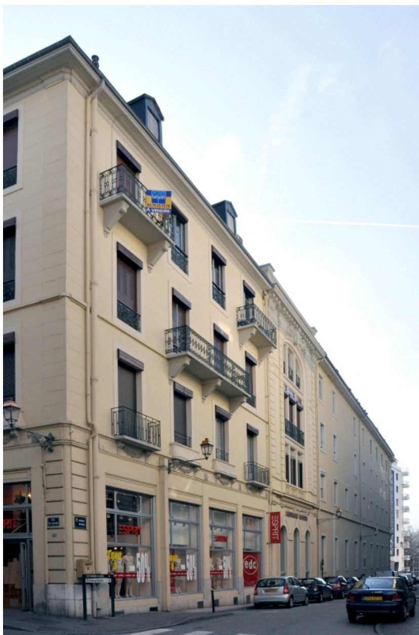
Vue d'ensemble : façade sur l'avenue Victoria
