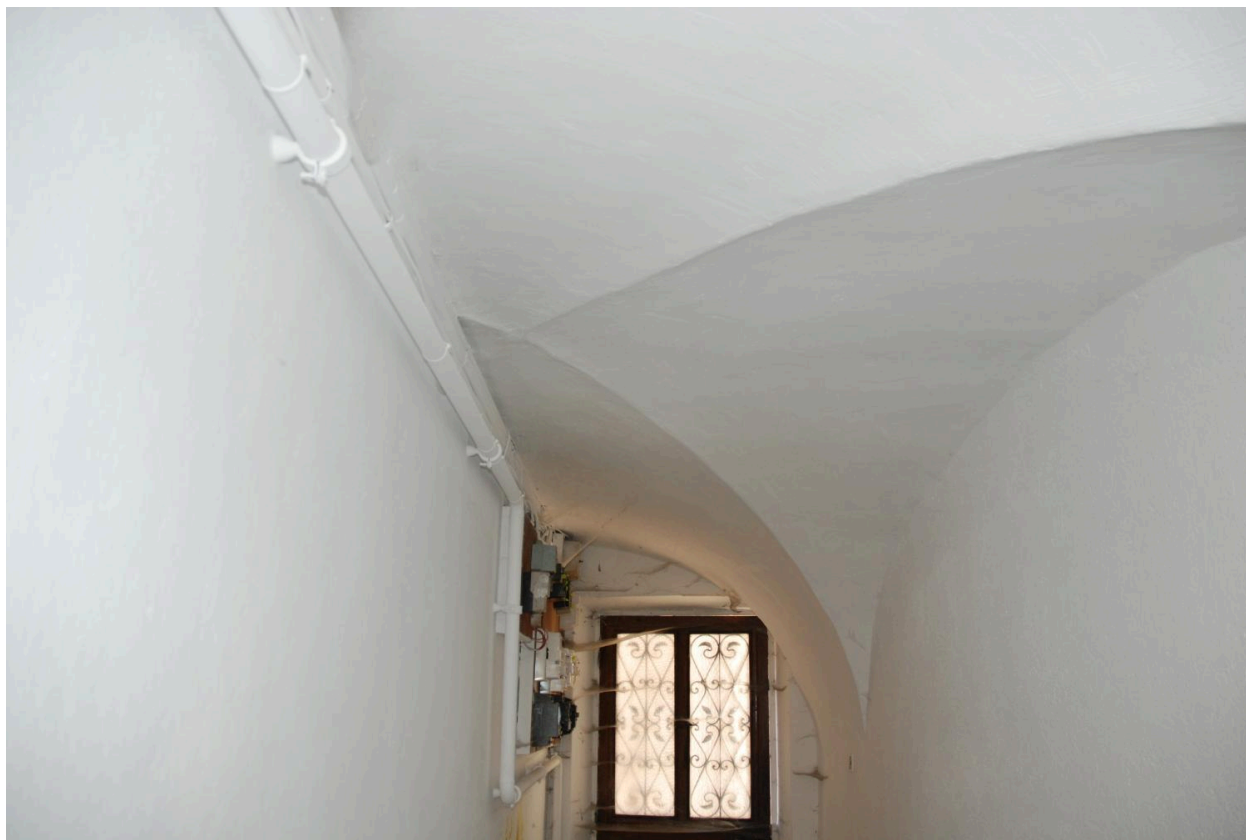
Vue intérieure de la pension de famille, étage de soubassement : couloir d'entrée.
