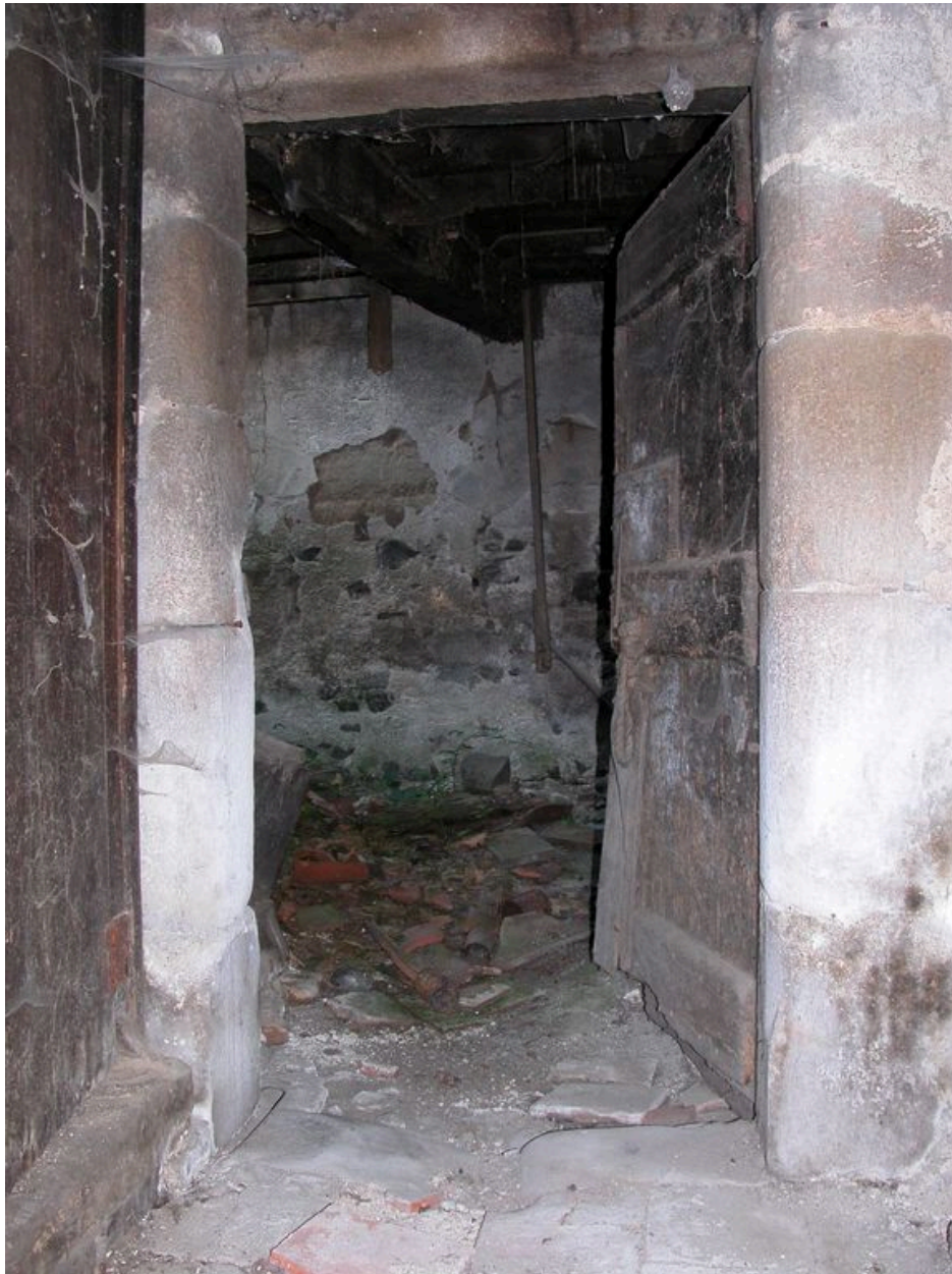
Porte entre le couloir et le cellier ; à gauche, départ de l'escalier.
