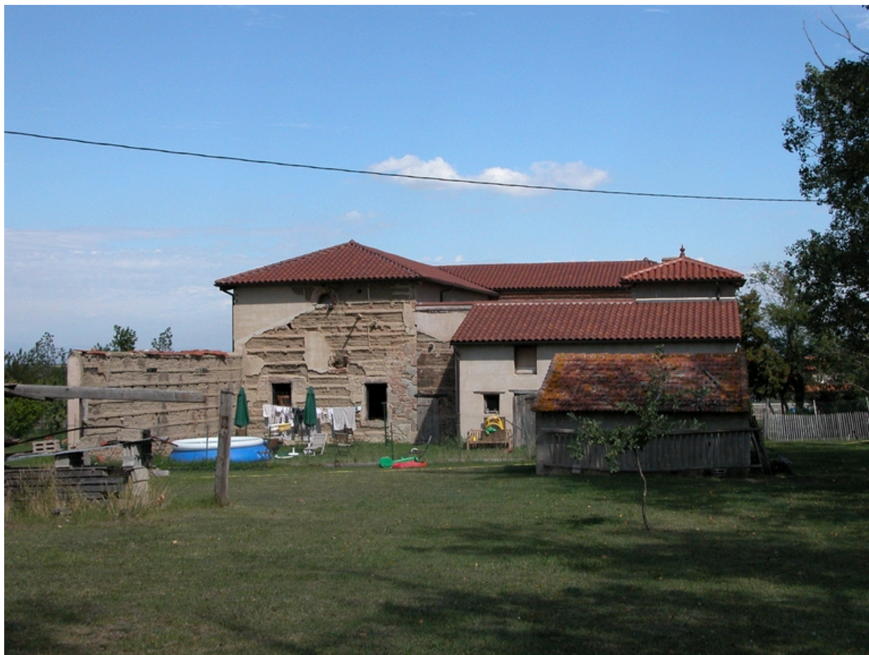
Vue d'ensemble de la demeure depuis l'ouest.
