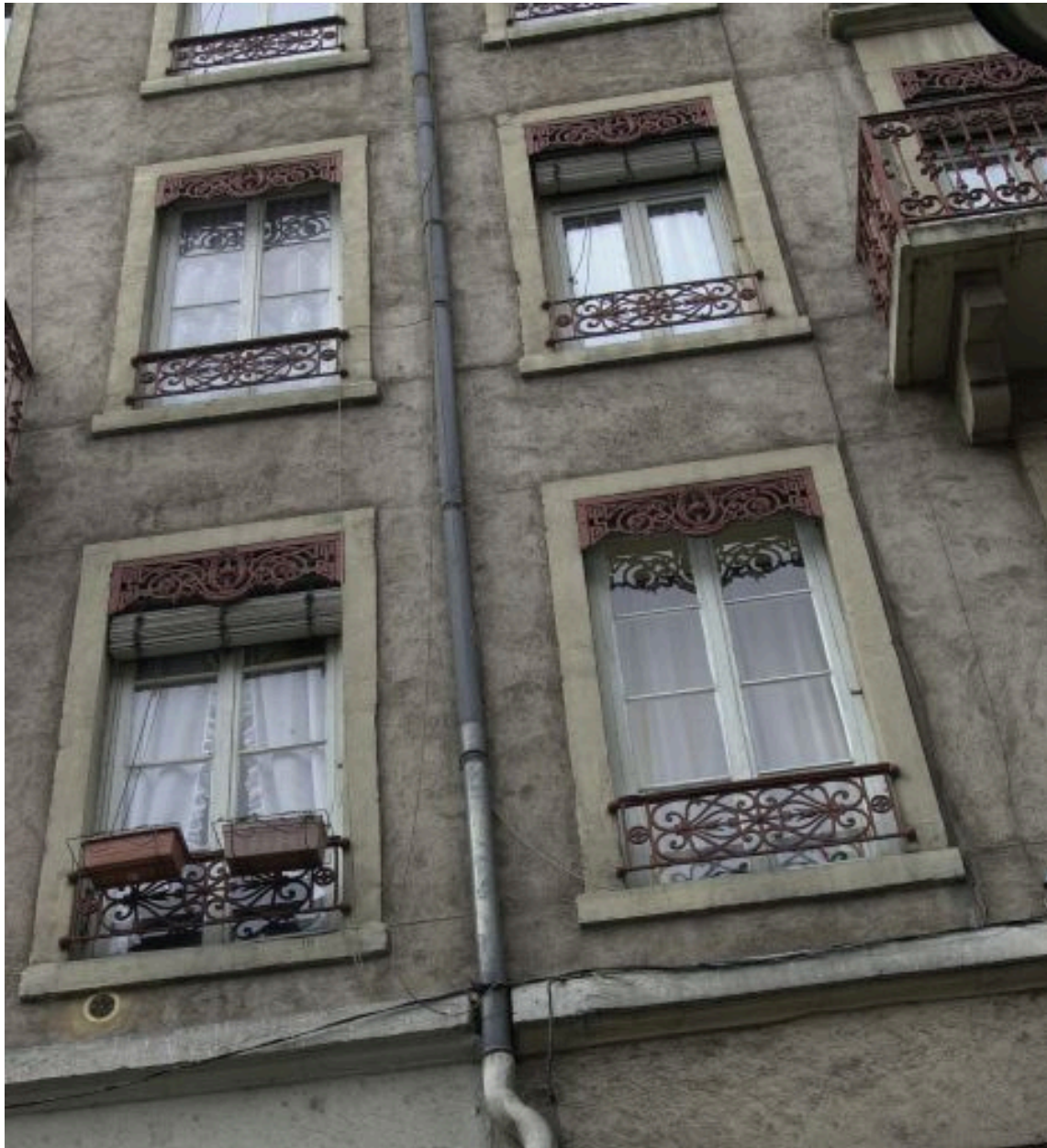
Détail des fenêtres : garde-corps et lambrequins
