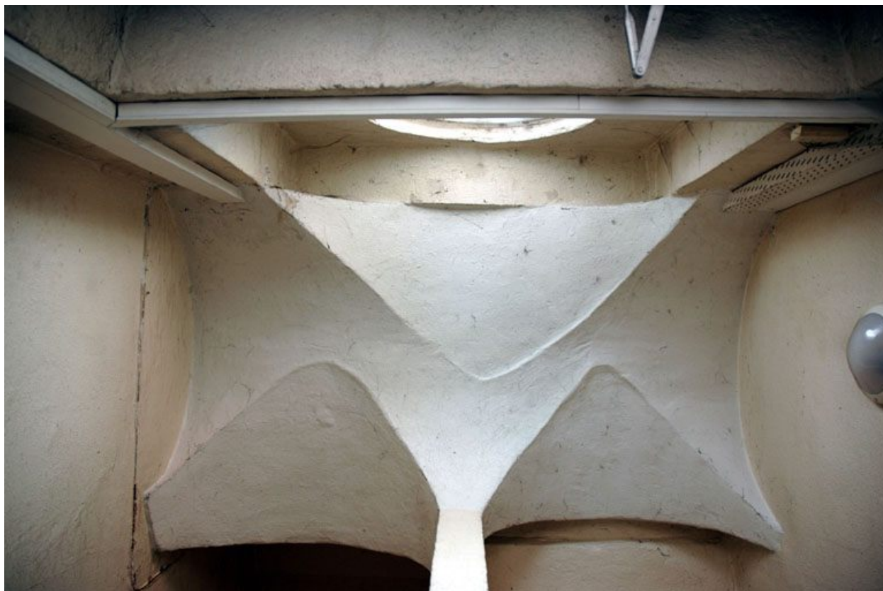
L'escalier de service : les paliers sont voûtés de berceaux à lunettes
