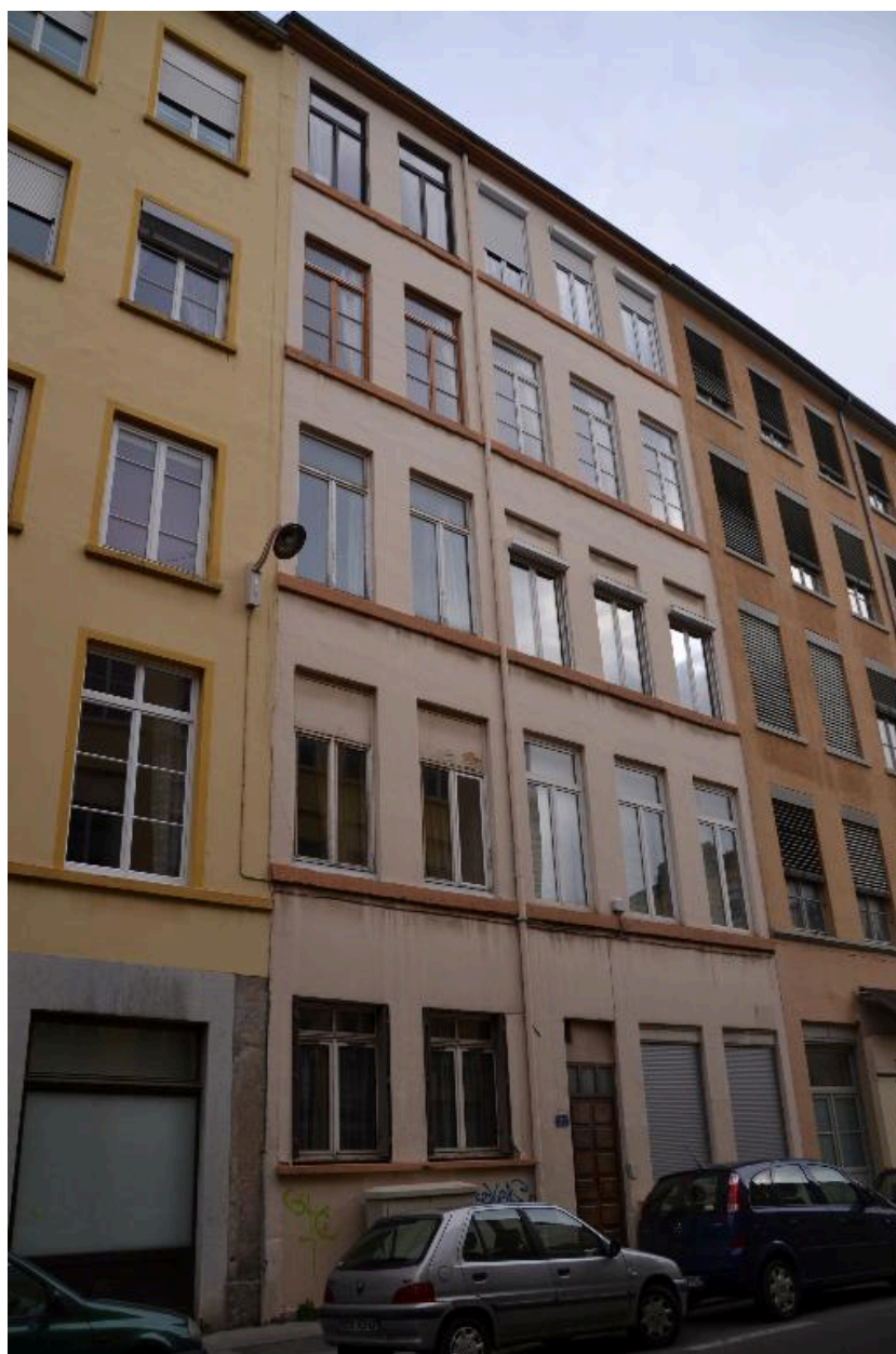
Vue d'ensemble façade sud
