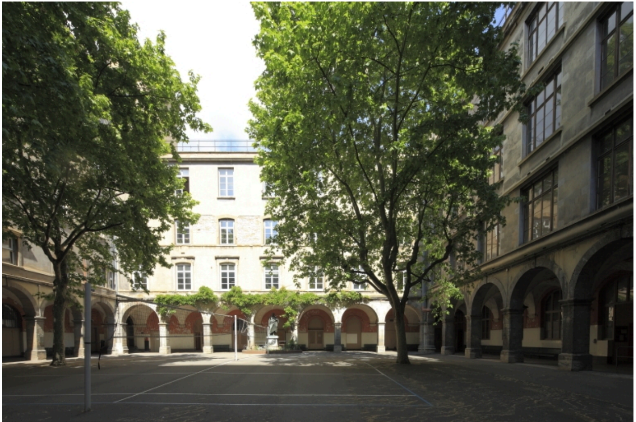
Cour du lycée. Façades est, nord, sud.
