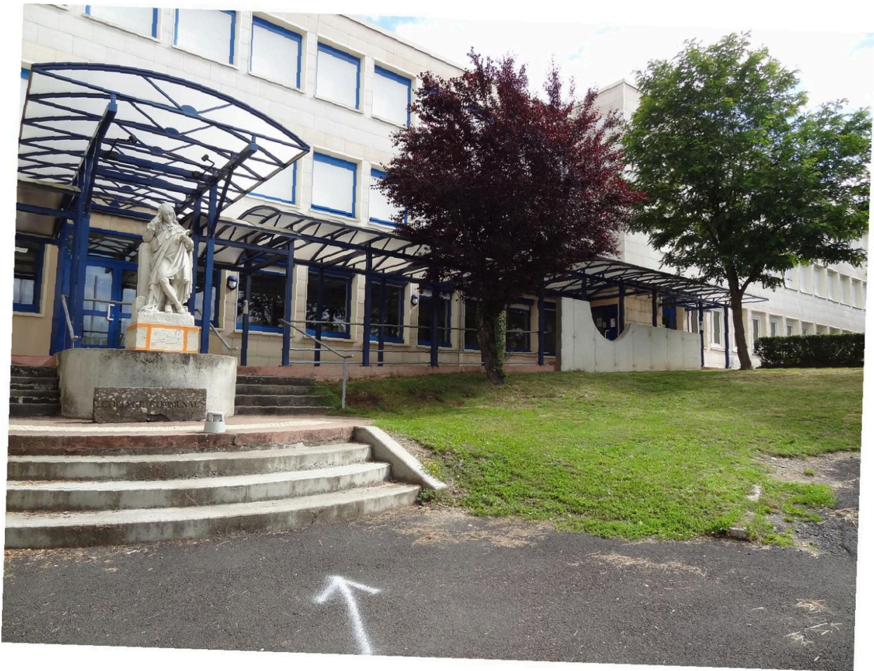
Vue depuis l'extérieur du lycée sur le corps de bâtiment nord.
