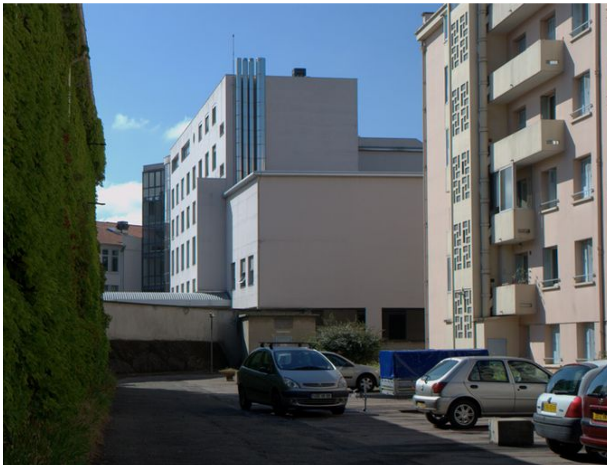
Elévations postérieure et latérale ouest du corps de bâtiment rue Claude-Veyron
