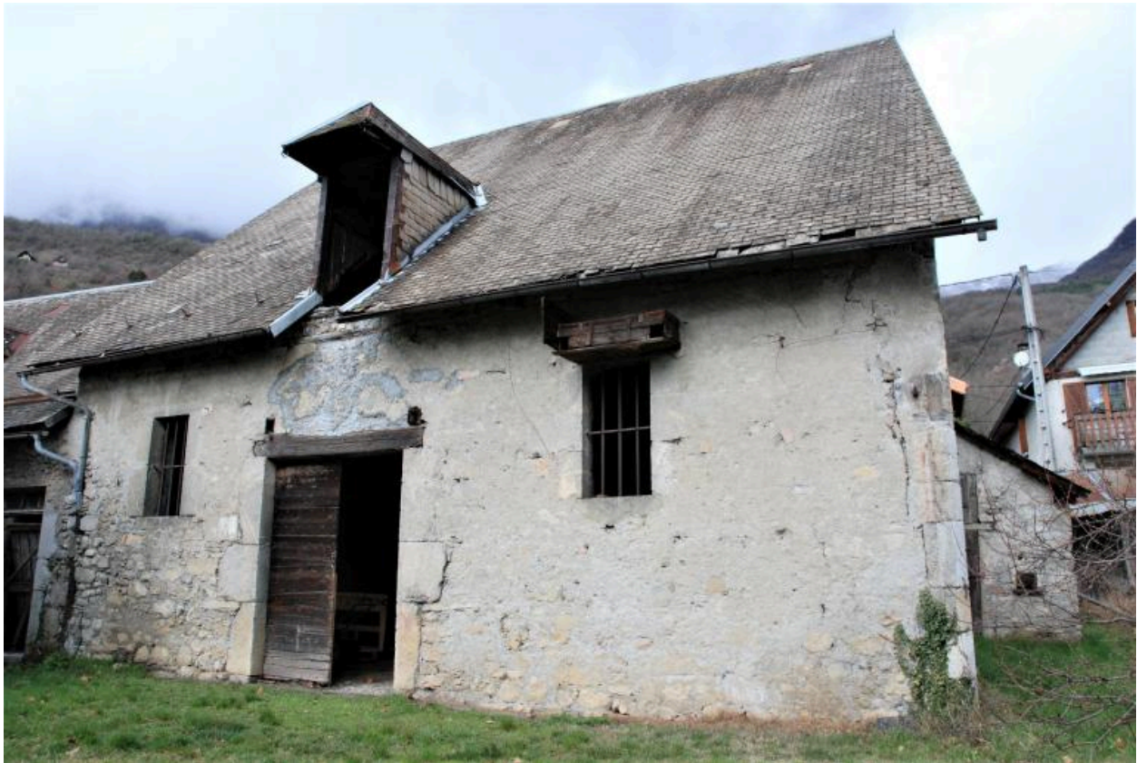
Bâtiment abritant les communs (étables, granges). Elévation principale, partie est.
